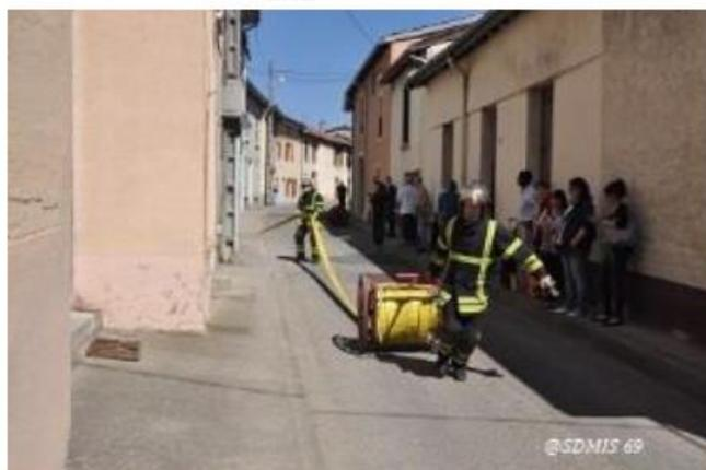
Illustration n°4 : Alimentation d'un engin pompe à l'aide d'une ligne de 70 sur dévidoir (Crédit photo @ SDMIS 69)
