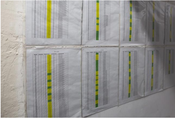
Le tableau de correspondance entre les canaux de gradation et les projecteurs.
