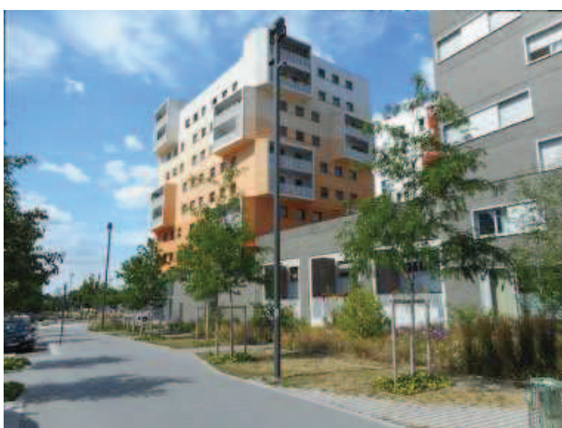
Eco-quartier des Docks – Saint-Ouen
