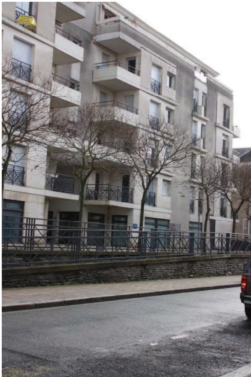
Figure 4. Le rehaussement des trottoirs dans le quartier Saint-Serge à Angers
