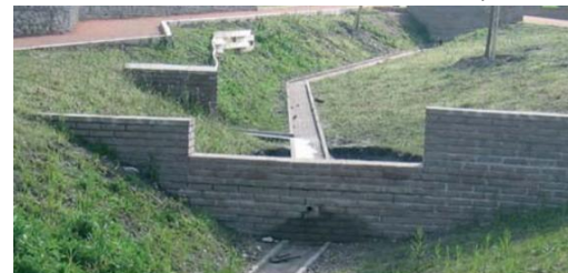
Noues végétalisées à Nanterre (Source : CG 92)
