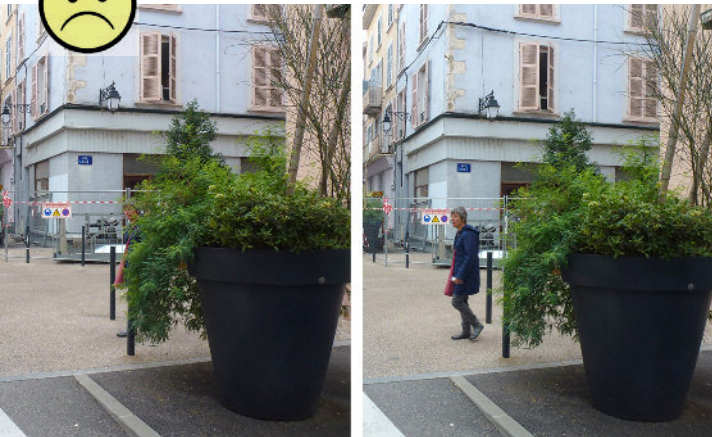
La végétation masque le piéton qui s'apprête à traverser
