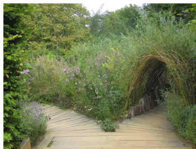
Cheminement en traverses de bois, Chaumont-sur-Loire
