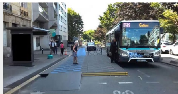
Solution inclusive à Montreuil : quai de bus « Vectoriel » de Zicla, avril 2020
