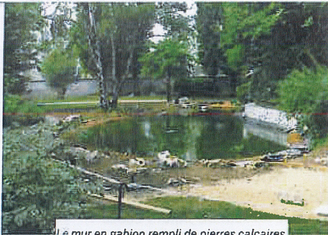
Le mur en gabion rempli de pierres calcaires régulera le PH de l'eau.
