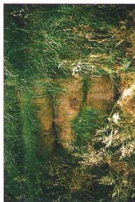
FIGURE 8 - Détail du géotextile retenant la terre végétale.
