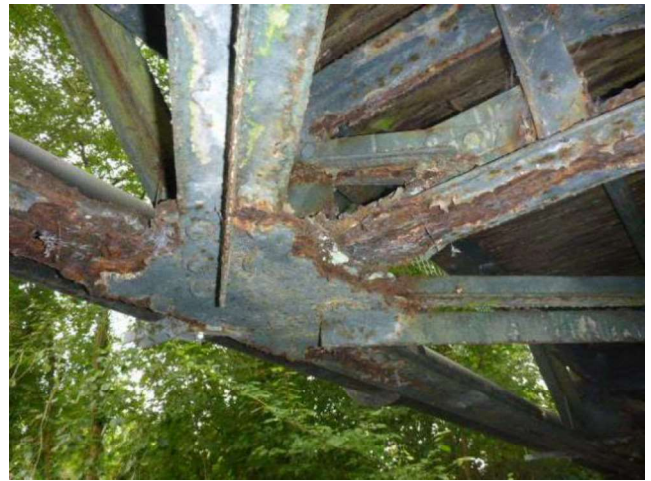
Défauts d'entretien d'ouvrages métalliques. Ces défauts affectent assez souvent des parties difficilement visitables et très exposées aux venues d'eau
