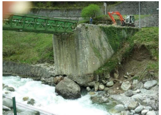
Affouillements de fondations causés par des régimes d'écoulement torrentiels (érosion puis disparition d'éléments de parties de fondations)
