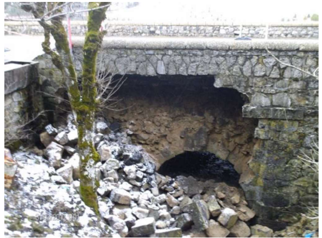
Décollement et dégradation du bandeau d'un ouvrage en maçonnerie sous l'effet de charges excentrées (absence de trottoir), puis effondrement quelque temps plus tard
