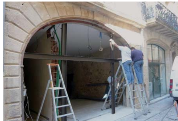
Réhabilitation de la façade
