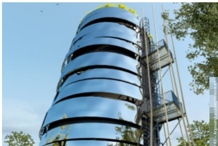
Ce château d'eau original, de 19,5 m de haut, stockera de l'eau chaude pour le réseau de chaleur.
